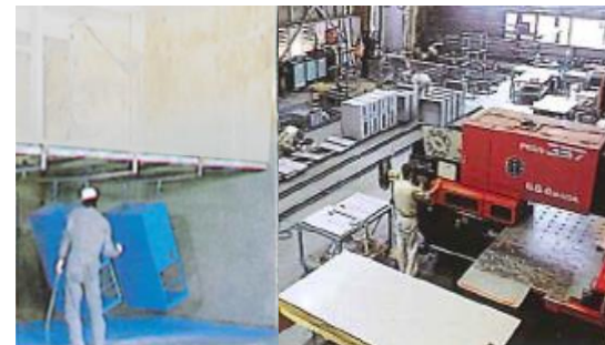
涂装/制罐工厂(D栋)
