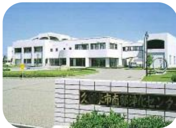
久留米市南部净化中心
