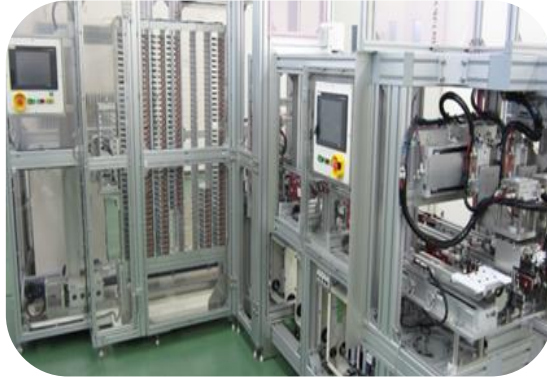
●自動組裝搬運系統 配合產品組裝流程的生產線構成
