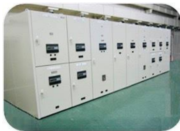
JEM1425 MW高壓電盤
