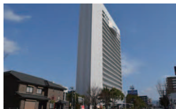
久留米市役所(特高盤納入)
