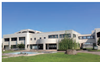
久留米市南部浄化センター
