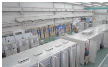
組立検査工場
