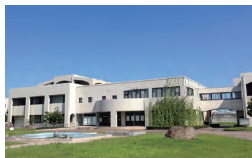
久留米市南部浄化センター
