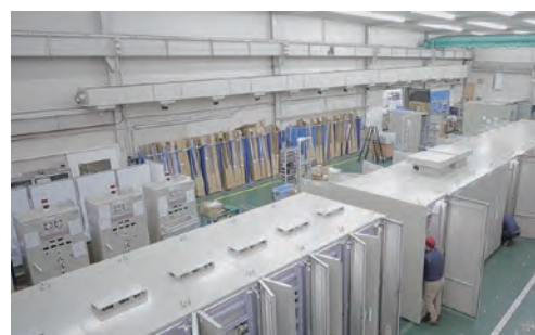
組立検査工場
