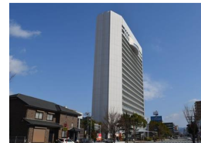
久留米市役所（特高盤納入）
