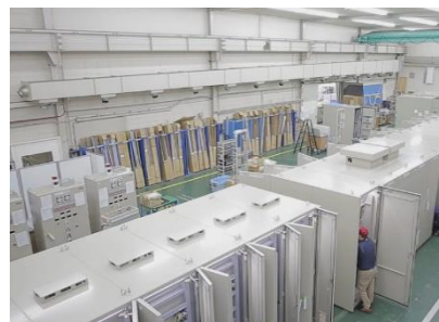
組立検査工場
