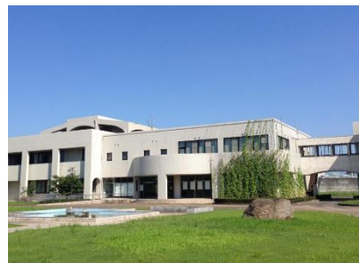
久留米市南部浄化センター
