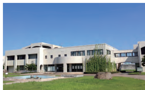
久留米市南部浄化センター
