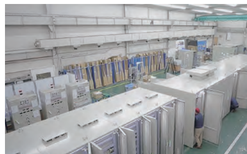
組立検査工場
